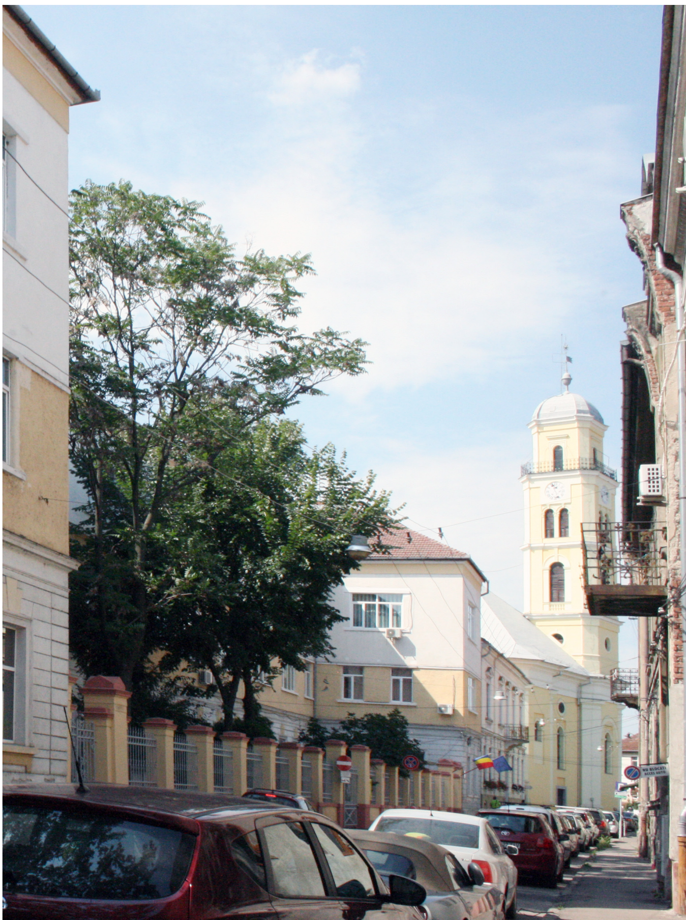
Fig. 51 Perspectivă de pe strada Jokai Mór asupra Bisericii Reformate din Orașul Nou de pe strada Primăriei
