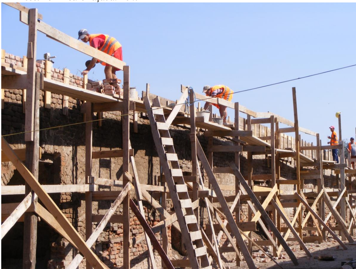
Lucrări arhitectură Corp L - Strada Breslelor
