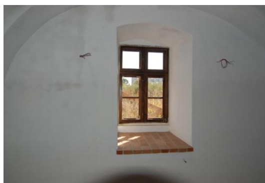
Tâmplărie uși interioare și ferestre, glafuri de cărămidă și echipare termică Corp H - Muzeul Pâinii
