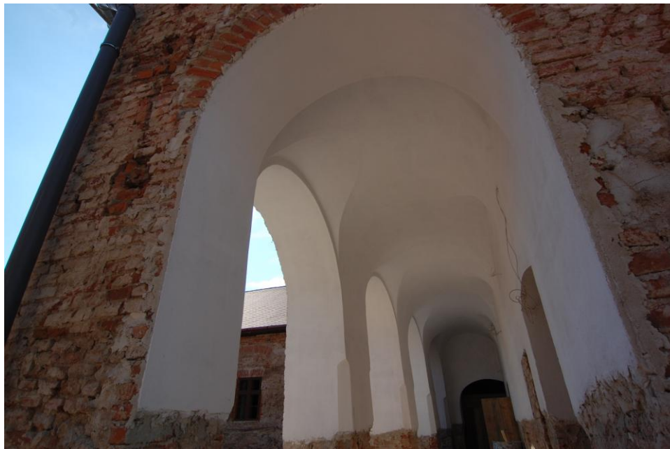
Tencuieli bolți exterioare Corp H - Muzeul Pâinii
