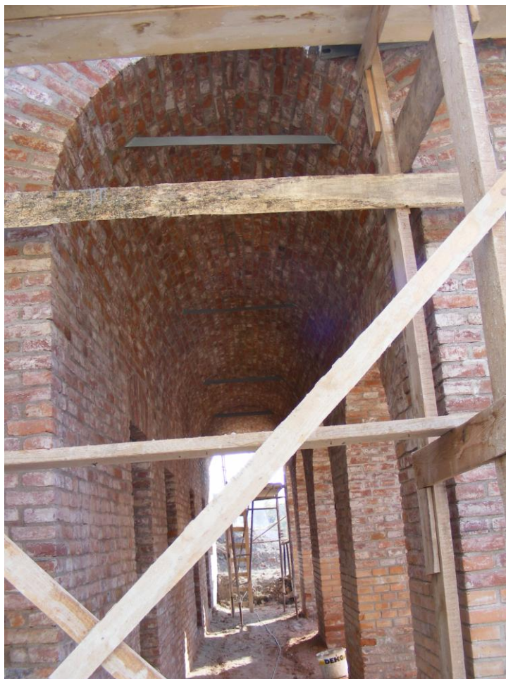
Lucrări de arhitectură refacere sistem boltire și "pridvor" Corp M - Multiplex cultural
