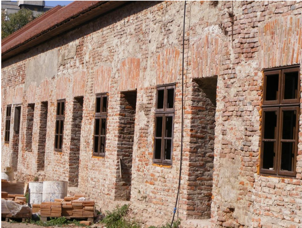
Tâmplărie ferestre Corp K - Strada Breslelor
